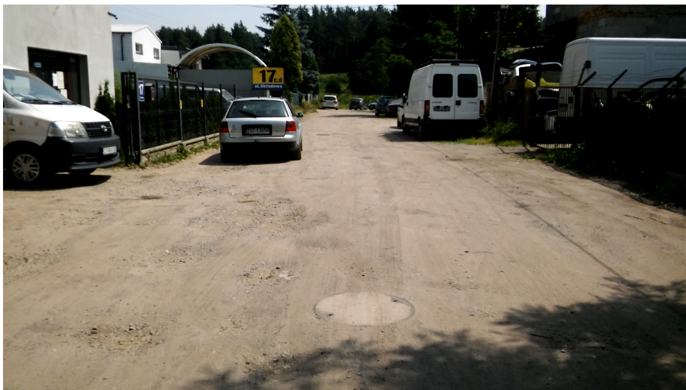
Odcinek ul. Składowej przed inwestycją...
