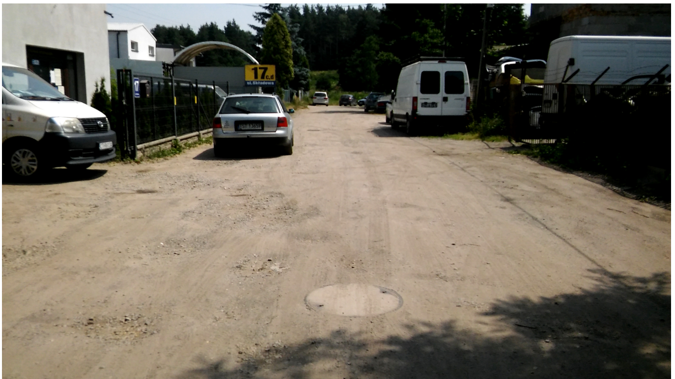
Odcinek ul. Składowej przed inwestycją...
