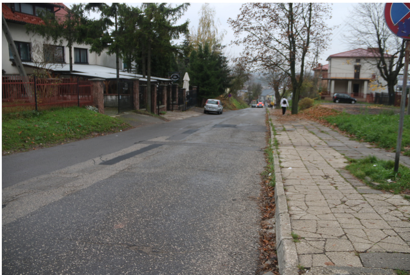
Ulica Kilińskiego po remoncie:
