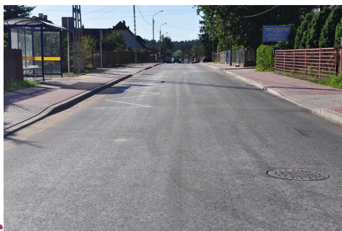
Południowa po przebudowie
