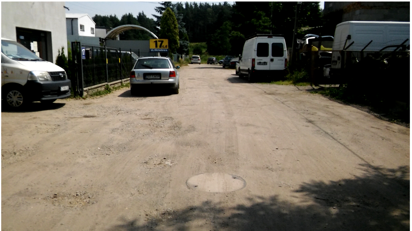
Odcinek ul. Składowej przed inwestycją...
