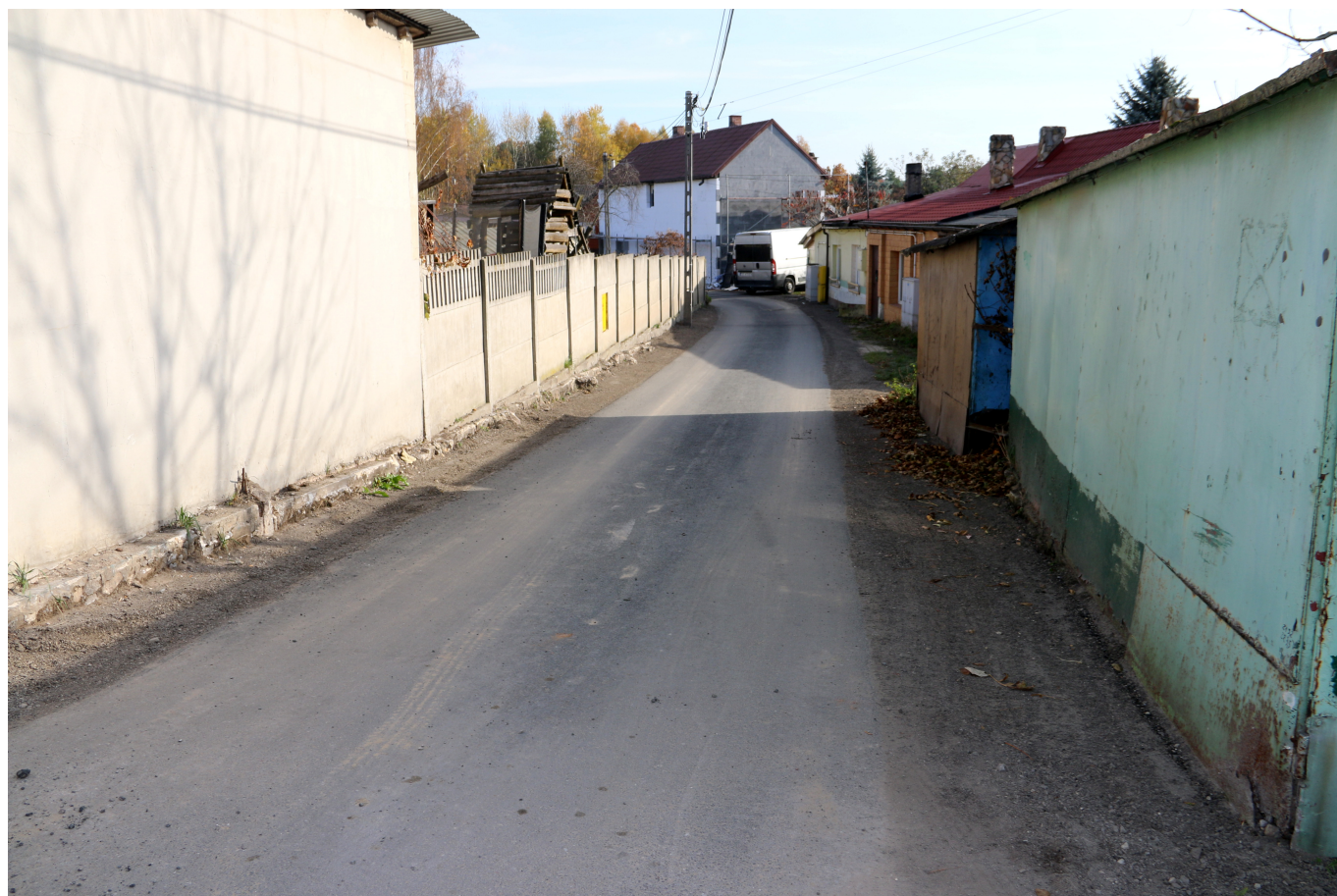
Ulica Owocowa z nową, asfaltową nawierzchnią.
