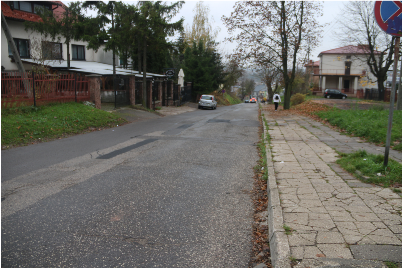
Ulica Kilińskiego po remoncie:
