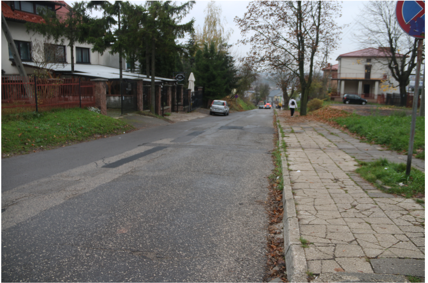
Ulica Kilińskiego po remoncie:
