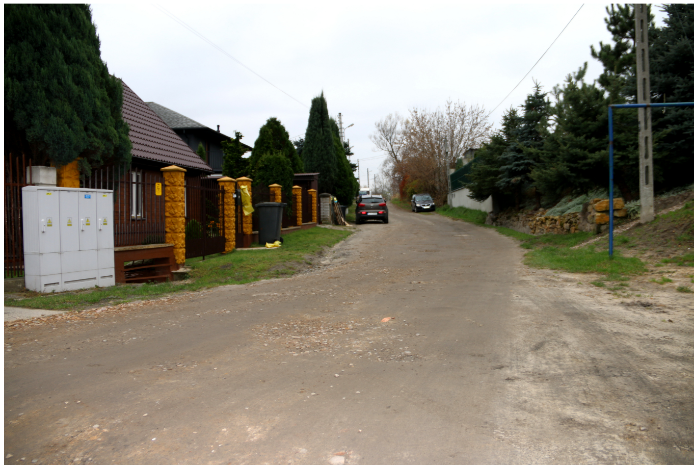
Ulica Zacisze przed inwestycją.
